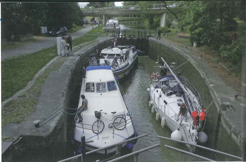
ロック(閘門)とは、水位の異なる水面を行き来するために考えられた装置。写真奥の水面は、ロック内の水面に比べて、かなり高い位置にあることが分かると思う
